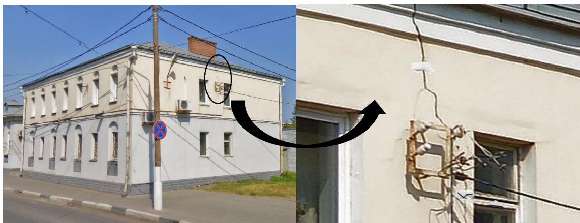
Рис. 4. Обследование здания в городе Коломне
