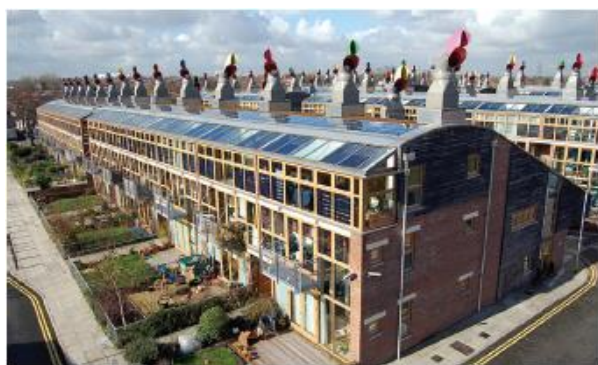
Рис. 3. Кровля «активного» зеленого здания
