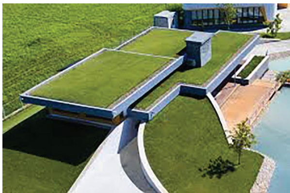
Рис. 2. Кровля здания с озелененной поверхностью
